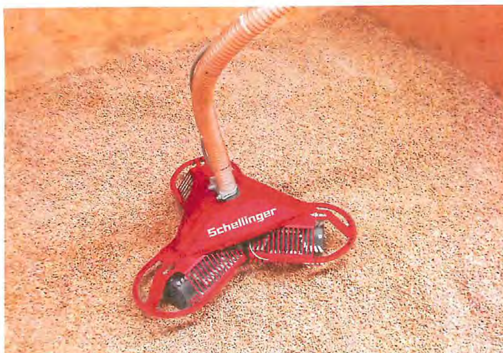
Das Maulwurf genannte Saugsystem arbeitet sich von oben nach unten durch den Pelletvorrat. Laut Hersteller kann die neue Austragsvariante E3 in Pelletlagern mit Fassungsvermögen von bis zu 60t eingesetzt werden und trägt den Tagesbedarf eines 100-kW-Pelletkessels (rund 200 kg) innerhalb von 15 bis 20 min aus. Bild: Schellinger
